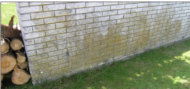
Overfladen rengøres for snavs, alger m.m.
