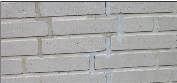
Sætningsrevner udbedres med Skalflex Armeringssystem.
