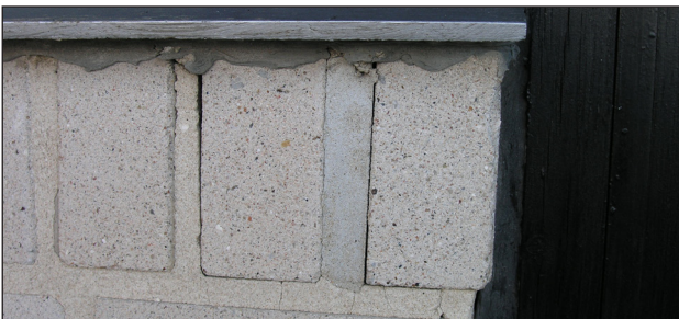
Løst murværk mures om.
