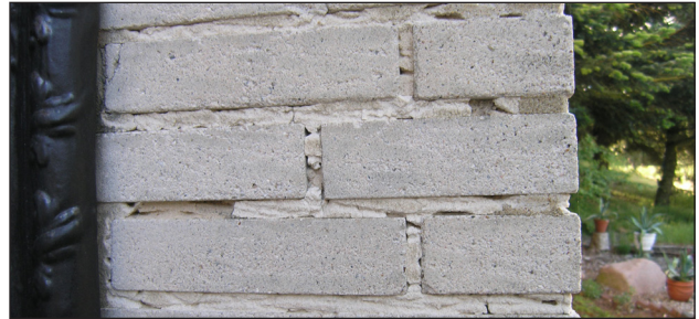
Løse fuger skæres ud og fuges om.
